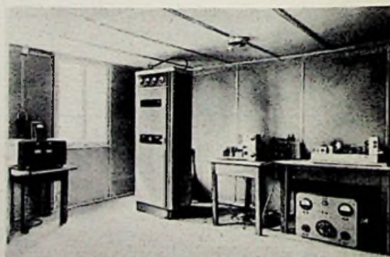
Der erste deutsche UKW-Rundfunksender. Er wurde am 28. Februar 1949 in München-Freimann aufgestellt und hatte 250 W Ausgangsleistung (Bild: Rohde & Schwarz)
